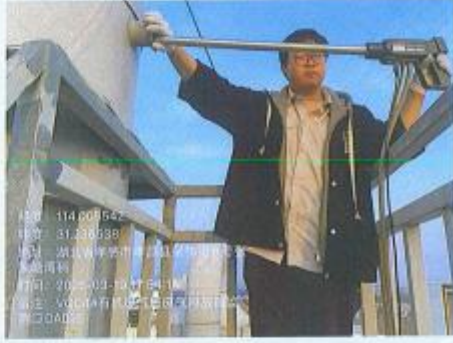
VOC4#有机废气塔废气排放筒监测口 DA025
