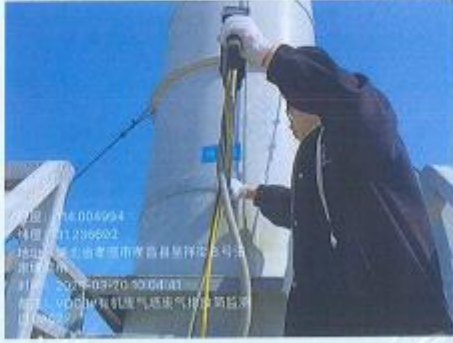
VOC3#有机废气塔废气排放筒监测口 DA027
