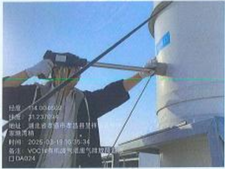
VOC1#有机废气塔废气排放筒监测口 DA024
