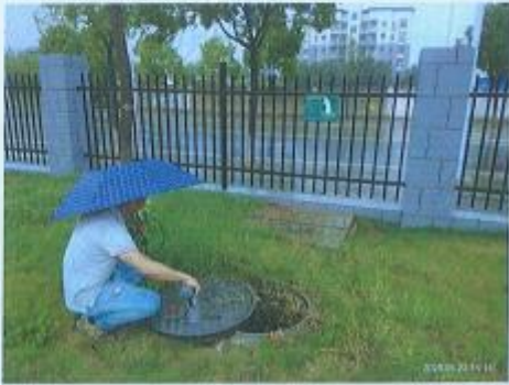
厂区雨水排口 YS004
