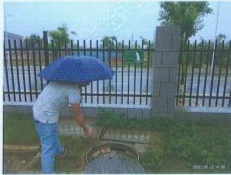
厂区雨水排口 YS002
