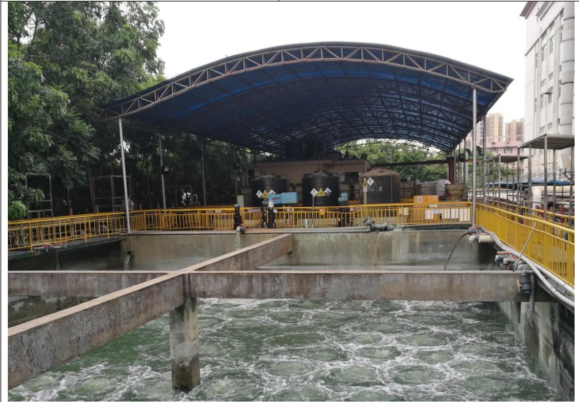
污水站地下池体集中分布区域
